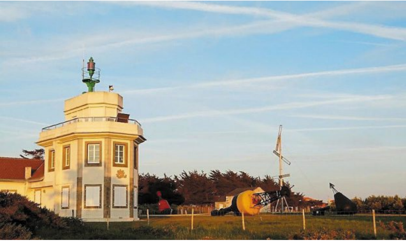
Bâtiment en cours de rénovation, le mât sémaphorique, à droite, fera également l'objet d'une remise en état.
